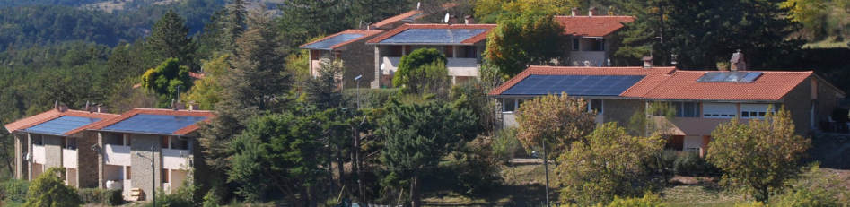
Centrale villageoise dans les Baronnies provençales
